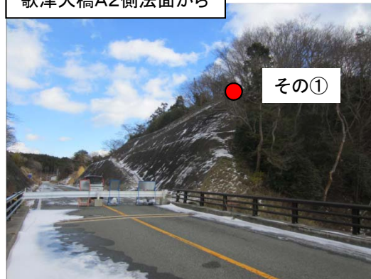
歌津大橋A2側法面から
