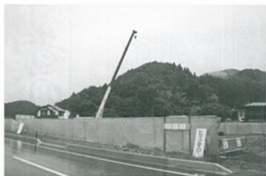
工事が進む仮設店舗
