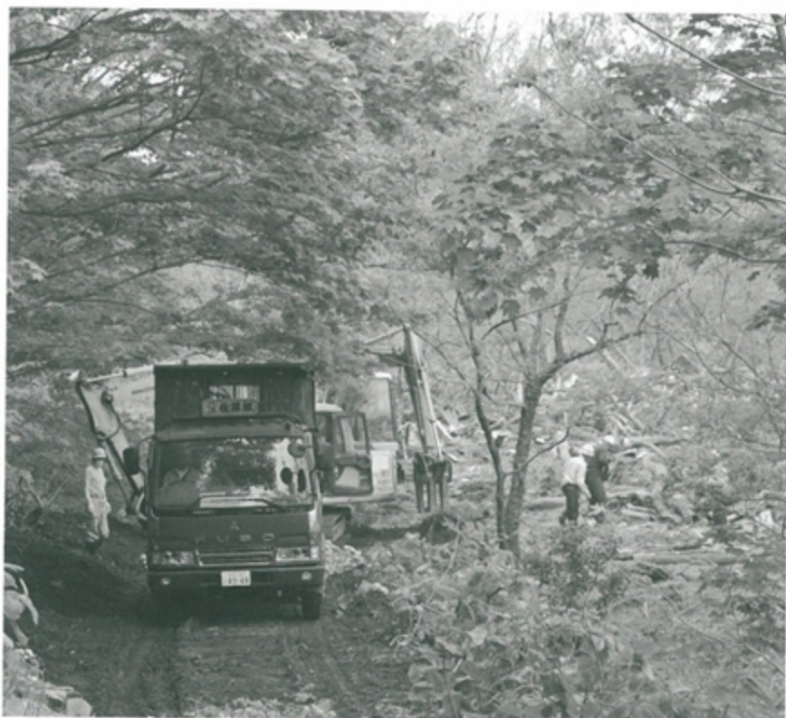
小本川岸のがれき撤去作業
